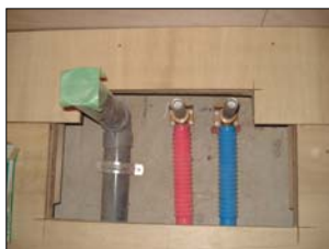
弊社施工事例
